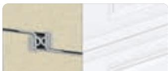
Joint InterLok™ entre les panneaux qui bloquent les infiltrations d'air pour un bris thermique remarquable
